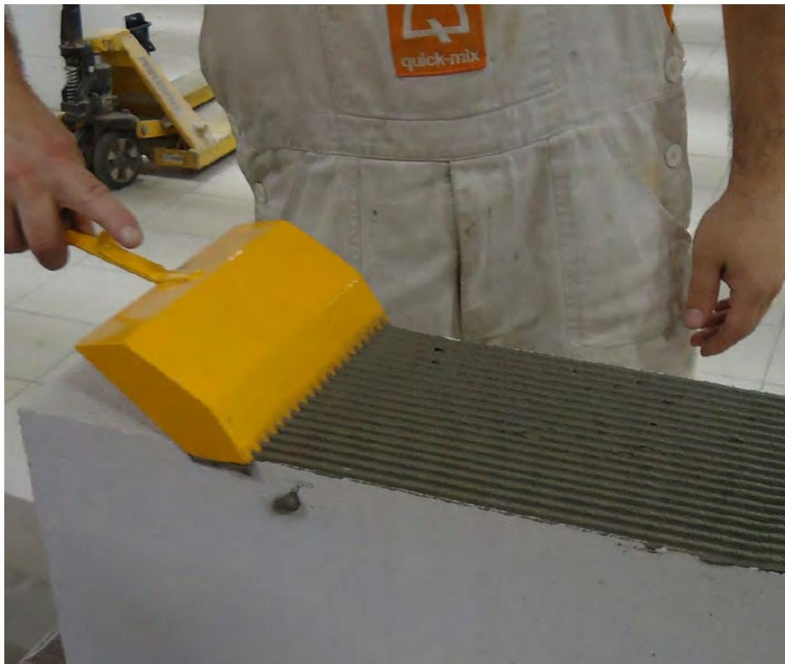
Смесь для тонкошовной кладки ячеистого бетона quick-mix GBK
