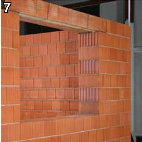
Под отделку штукатуркой рекомендуется использовать керамические перемычки
