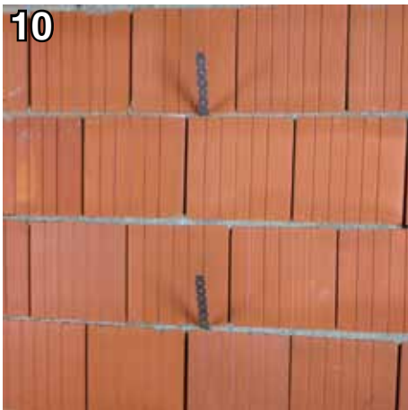
Количество анкеров соединяющих внутренние перегородки с несущими стенами определяется по расчету. Анкеры устанавливаются через каждые 2 ряда блоков
