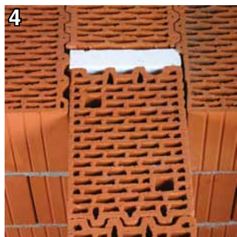
4 Конструктивные узлы должны соответствовать требованиям строительных норм. При перевязке внутренней стены с наружной устанавливаем термовкладыш
