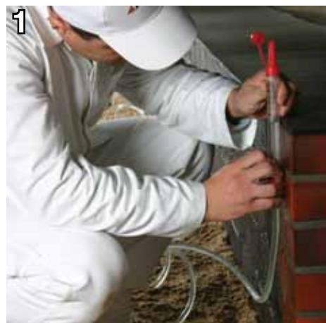
1 Установка горизонтальной гидроизоляции
