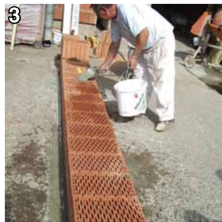
3 Перед укладкой блоки необходимо смачивать водой
