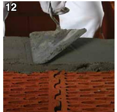
Под перекрытия необходимо уложить постель из цементно-песчаного раствора
