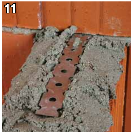
Количество анкеров соединяющих внутренние перегородки с несущими стенами определяется по расчету. Анкеры устанавливаются через каждые 2 ряда блоков
