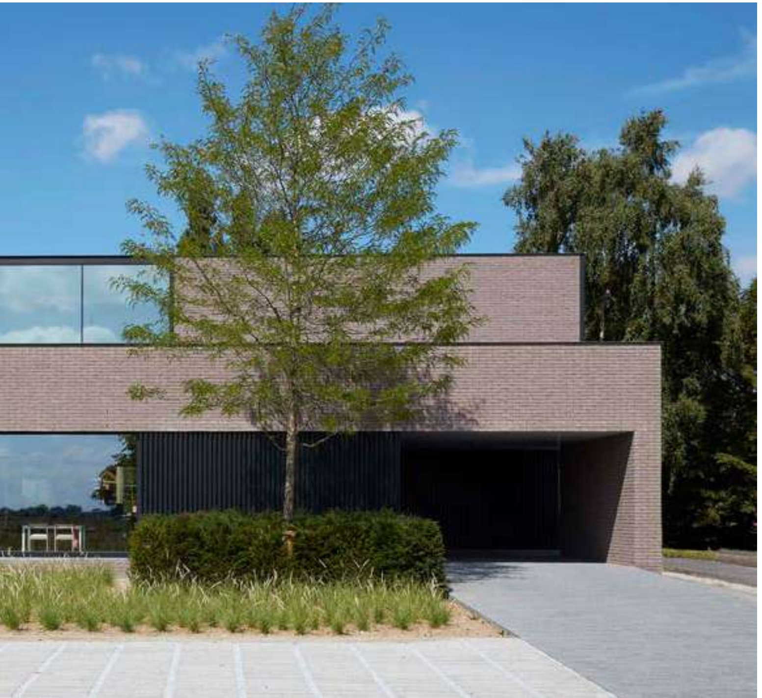
Архитектурное ателье Steven De Jaeghere, г. Тилт
