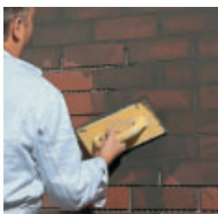
Швы закрытопористых плиток затачивают Раствором-шламом RSS (точно так же как и кафельные плитки) с помощью губчатого шпателя ...
