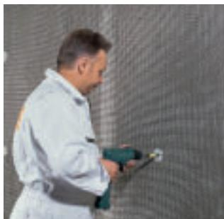
Затем через армирующую сетку PUG плиты крепят тарельчатыми дюбелями LOBATHERM и головки дюбелей шпаклюют RAS способом «мокрое по мокрому». Минимальная общая толщина армирующей слоя составляет 7 мм.
