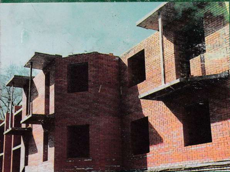
Москва, ул.Казакова. Дом облицовывается кирпичом АО "Керма"
